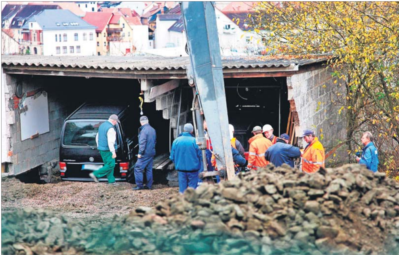
Die Pkw sind geborgen, die Garage soll am Mittwoch abgerissen werden.
